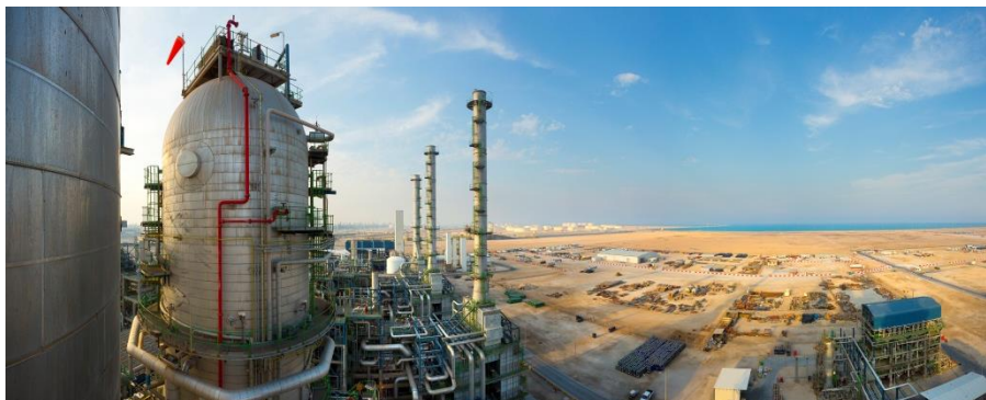
ORYX GTL, Qatar
